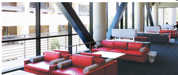
شکل ۱۹-۷ مهاربندهای کمانش‌تاب نمایان [۳۸].
