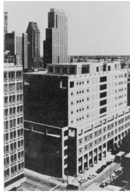
شکل ۶-۱۳ نمایی از ساختمان کتابخانه دانشگاه کونکورديا، مونترئال [۱۲].
