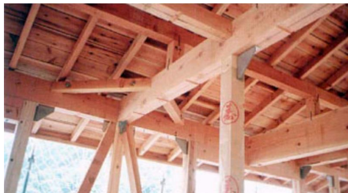
شکل ۱۰-۵ ساختمان چوبی مقاوم سازی شده با میراگرهای ویسکوالاستیک [۱۷].
