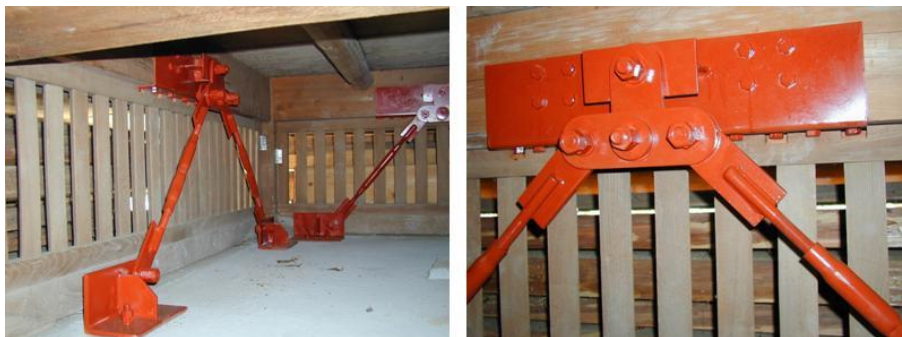
شکل ۷-۵ میراگر ویسکوالاستیک بکار رفته برای کنترل ارتعاش در سازه‌ای چوبی [۱۷].
