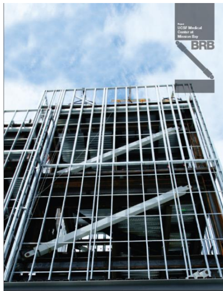
شکل ۳۳-۷ مهاربندهای کمانش‌تاب بکار رفته در مرکز پزشکی میشن بای [۳۸].
