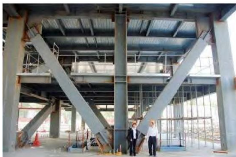
شکل ۷-۳۶ کاربرد مهاربندهای BRB طویل در یکی از ساختمان های دولتی تایوان [۳۹].
