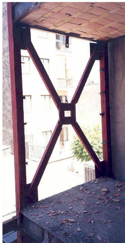
میراگرهای واقع شده در سازه
