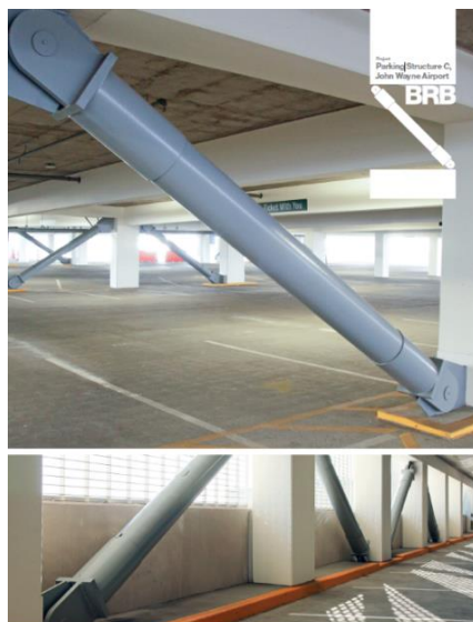
شکل ۳۴-۷ مهاربندهای بکار رفته در پارکینگ فرودگاه وین [۳۸].
